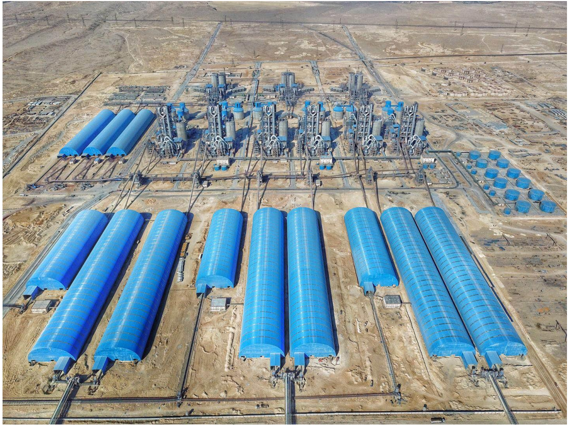
图 3：埃及 GOE Beni Suef 项目全景
